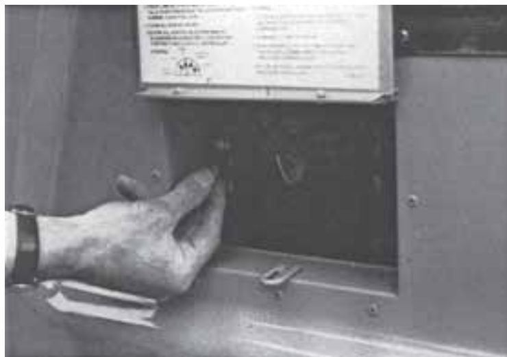
شکل ۱۵-۱۵- شیر استارت بار (Start/run) دو طرفه
