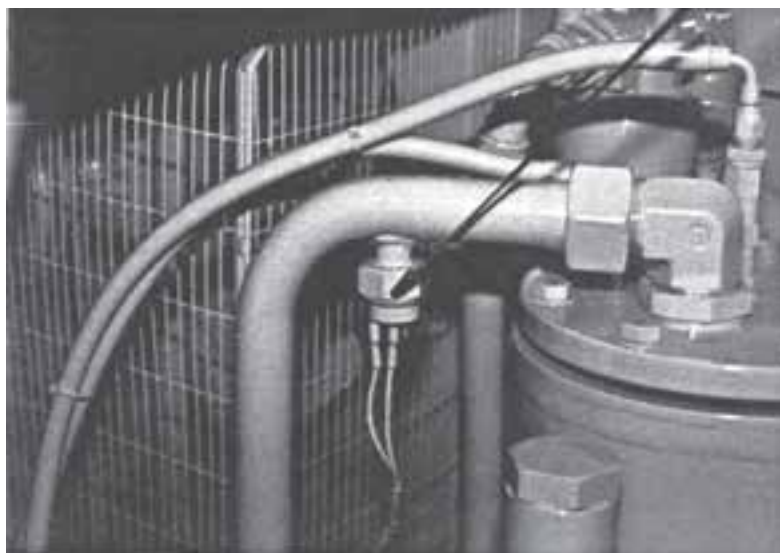
شکل ۳۹-۱۵- حس‌کننده (سنسور) هوای فشرده
