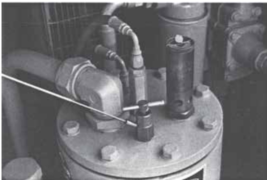
شکل ۳۰-۱۵- سوپاپ دستی تخلیه
