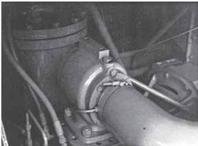
شکل ۱۷-۱۵- سوپاپ جلوگیری از خلأ
