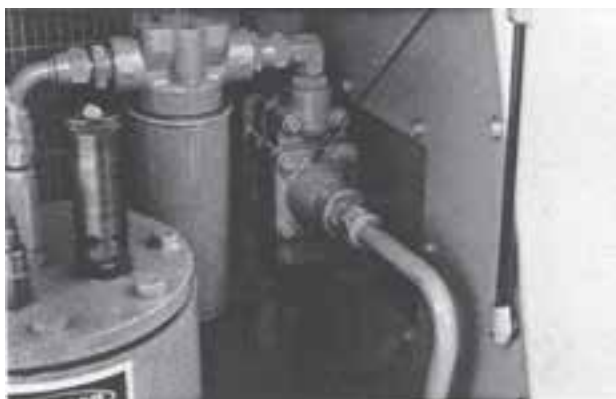
شکل ۳-۱۵- ترموستات
