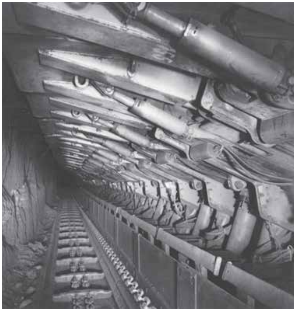
شکل ۹-۱۹- پایه قدرتی در کارگاه استخراج
