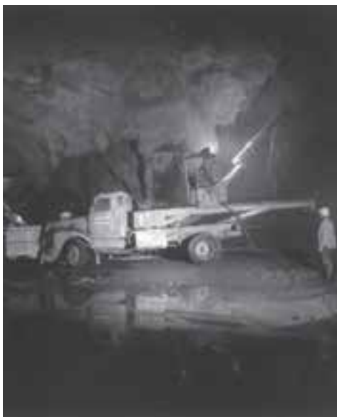
شکل ۷-۳۲- ایجاد یک لایه بتن با سیستم شاتکریت
