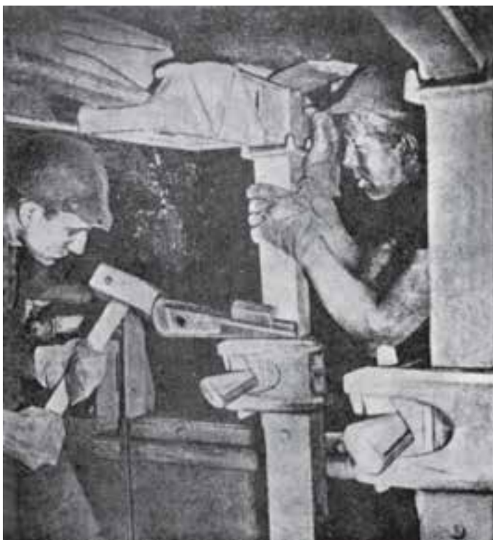
شکل ۹-۸ - نحوه نصب پایه‌های فلزی
