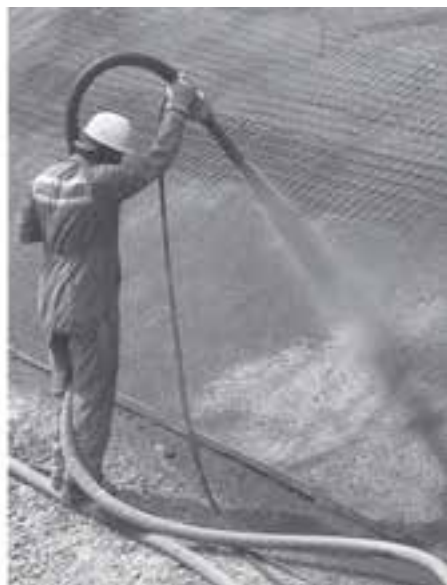
شکل ۷-۳۲- ایجاد یک لایه بتن با سیستم شاتکریت
