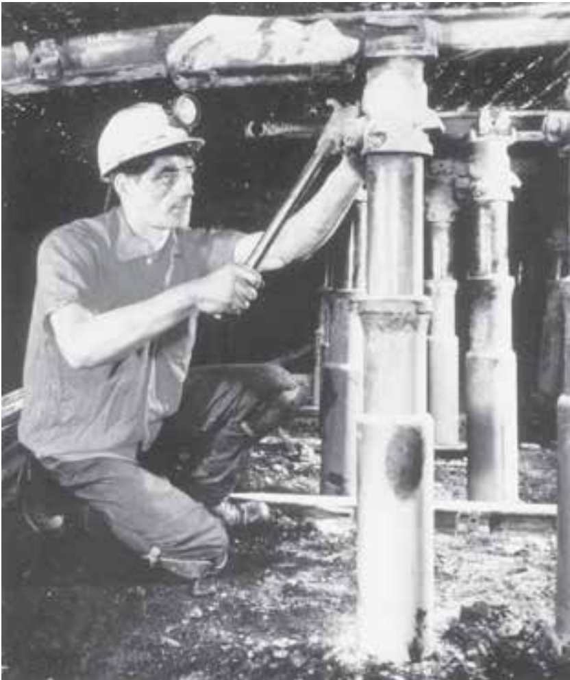
شکل ۹-۱۰- نصب پایه‌های هیدرولیکی در کارگاه استخراج
