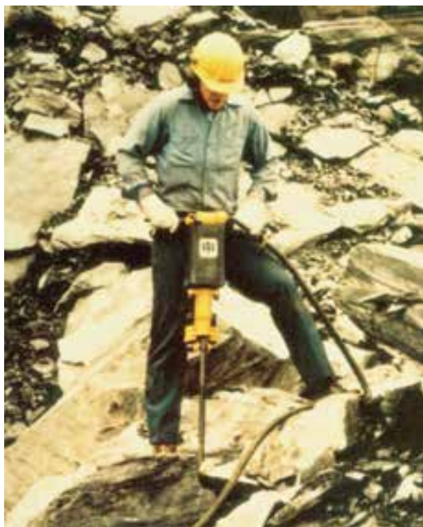
شکل ۵۳-۳- نحوه‌ی پیکور کاری
