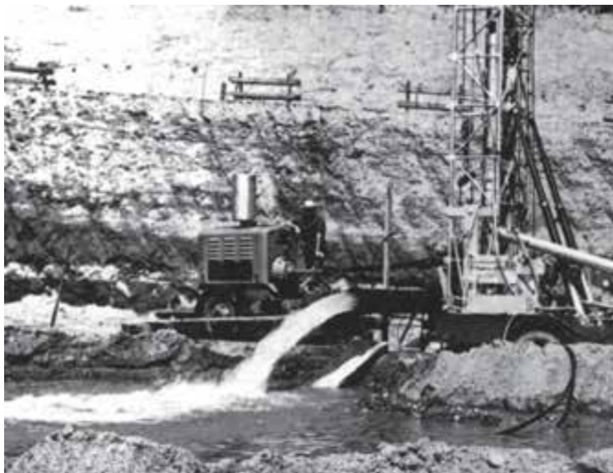
شکل ۷-۵- چاه عمیق با عمق بیش از ۳۰۰ متر
