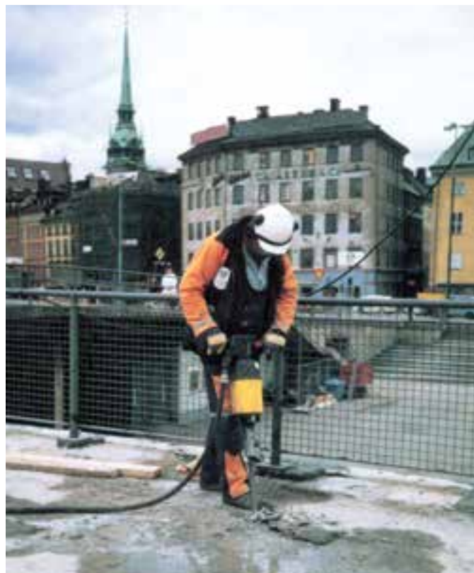
شکل ۳۸-۳- نحوه‌ی کار با انواع پیکور
