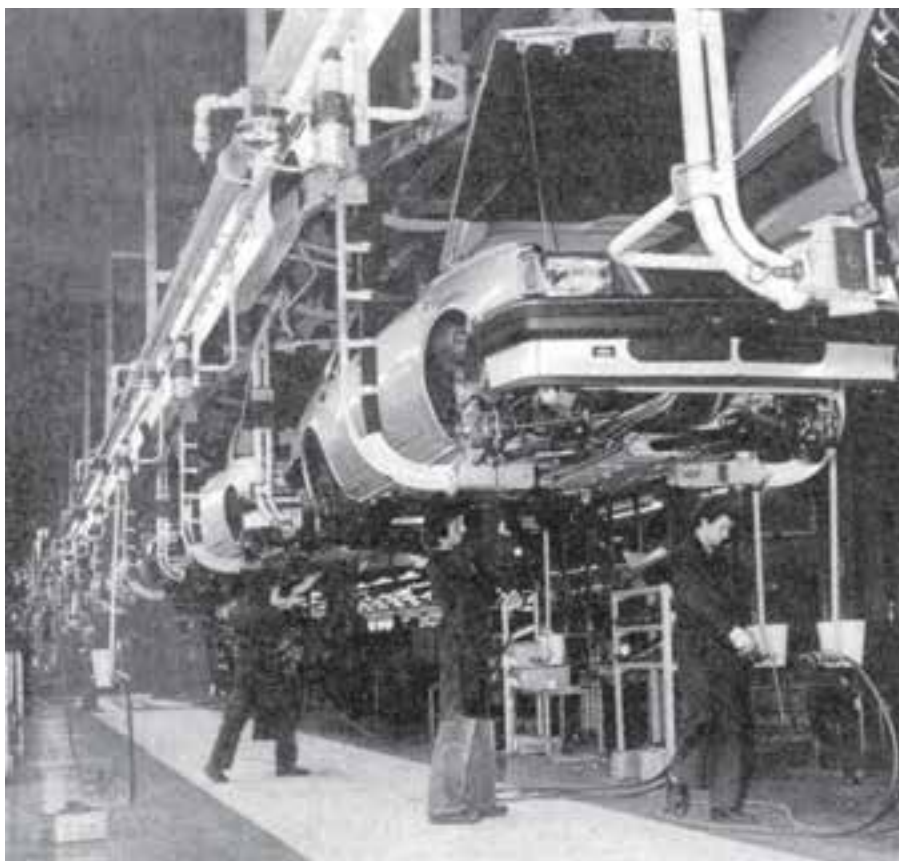
شکل ۱۰-۷- رنگ آمیزی بدنه‌ی اتومبیل نوعی حفاظت از خوردگی می‌باشد.
