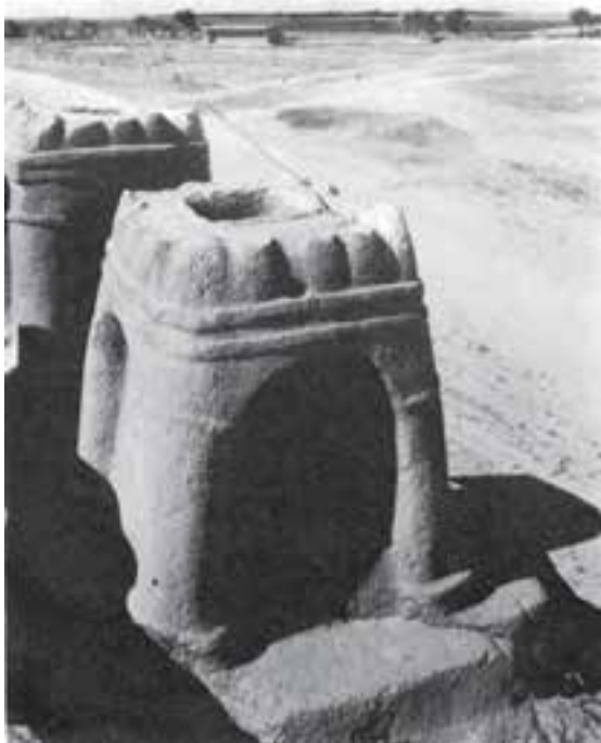
شکل ۱-۱۰- ۱- ساختمان آتشکده‌ای در نزدیکی تخت جمشید، نمونه‌ای از فرآیند هوازدگی است.
