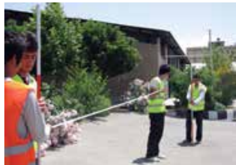
▲ شکل ۱-۳ - امتدادگذاری و مترکشی دهنه‌ها
