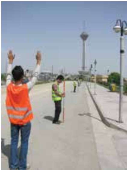
▲ شکل ۱-۳ - امتدادگذاری و مترکشی دهنه‌ها
