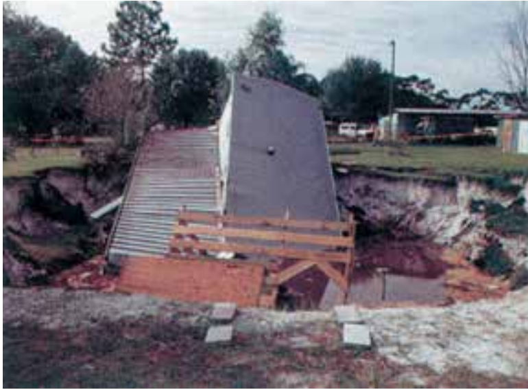
شکل ۳-۴- نشست و فرورفتن زمین به علت کاهش و اتمام آب‌های زیرزمینی
