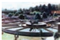
نمای بخشی از تصفیه‌خانه‌ی شهر تهران
