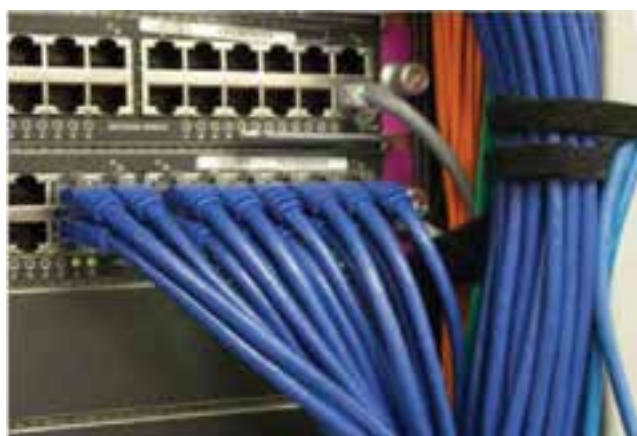
شکل ۲۵-۴- اتصال کابل‌ها به پیچ پانل
