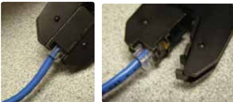
شکل ۴۷- پرس سوکت‌های کابل شبکه
