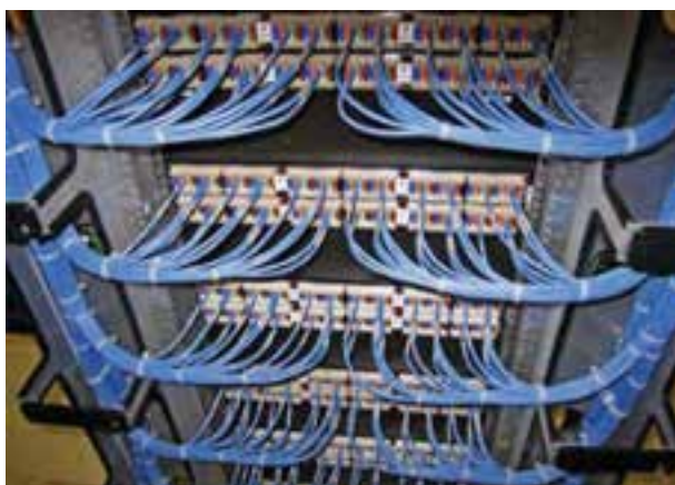
شکل ۲۸-۴- کابل کشی پشت پانل Loaded Patch Panel
