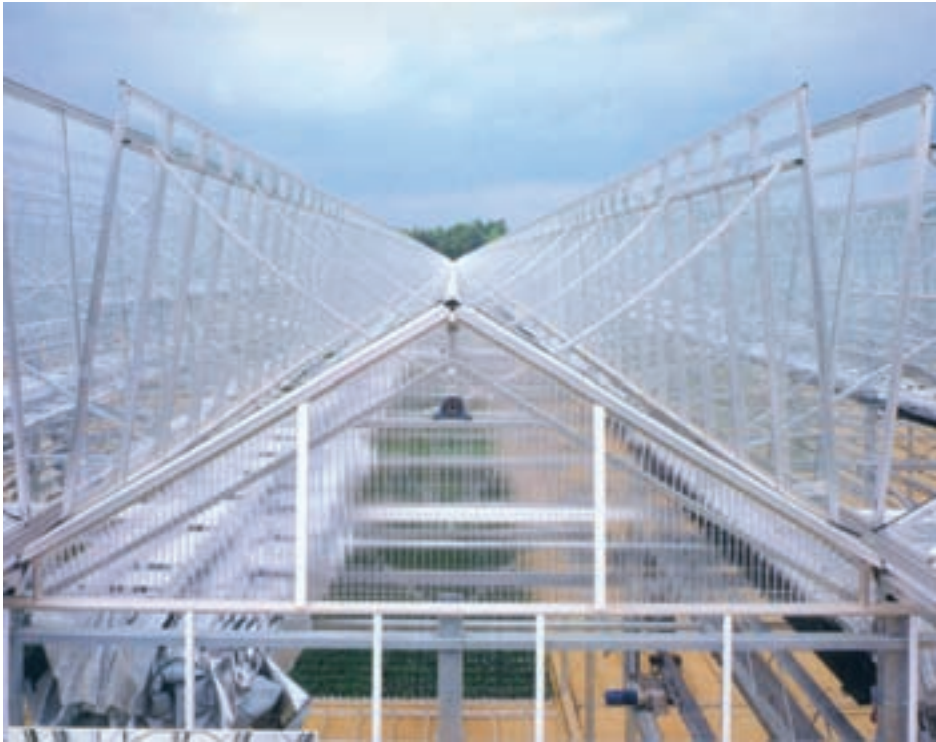
شکل ۱۷-۶- نمونه سقف یک گلخانه که به وسیله کامپیوتری باز و بسته می‌شود.
