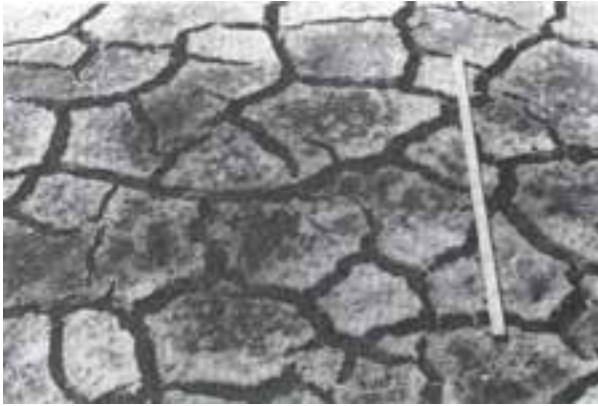
شکل ۱۹-۴- کف استخر پس از خشک کردن
