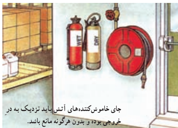
شکل ۱۲-۲-۱ محل نصب تجهیزات آتش‌نشانی
