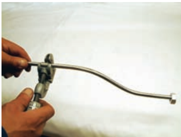
۲- بریدن لوله‌ی پیسوار به وسیله‌ی لوله‌بر
