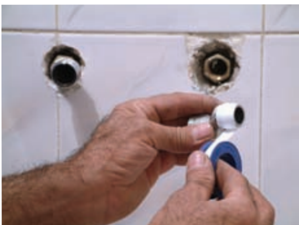
۳- پیچیدن نوار تفلون بر روی دنده‌ی \frac{3}{4} دنباله‌ی شیر
