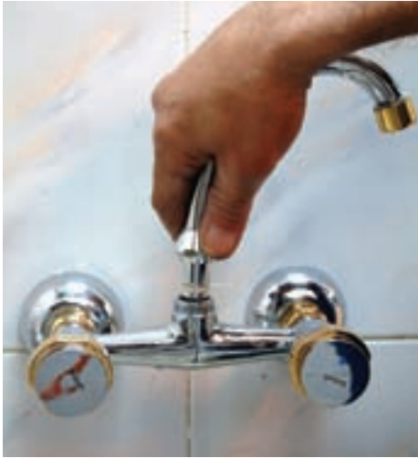
۱۳- جازدن عَلم شیر مخلوط در درون نافی شیر
