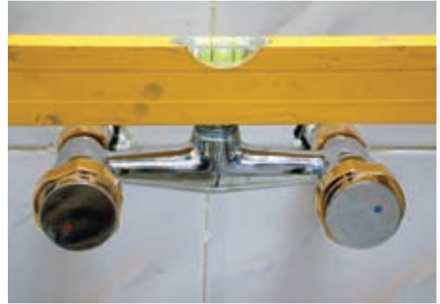
۱۲- سنجش تراز نصب شدن شیر مخلوط به وسیله‌ی تراز
