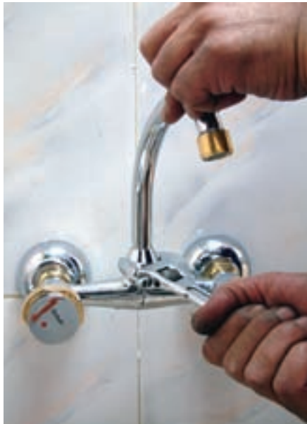
۱۵- سفت کردن مهره‌ی عَلم شیر مخلوط به وسیله‌ی آچار فرانسه
