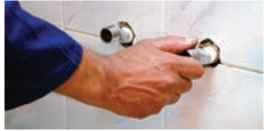
۴- بستن دنباله‌ها با دست به دهانه‌ي لوله‌هاي آب سرد و آب گرم
