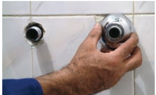
۸- بستن کاسه‌ها (قالپاق‌ها) به دنده‌ي \frac{3}{4} دنباله‌ها با دست
