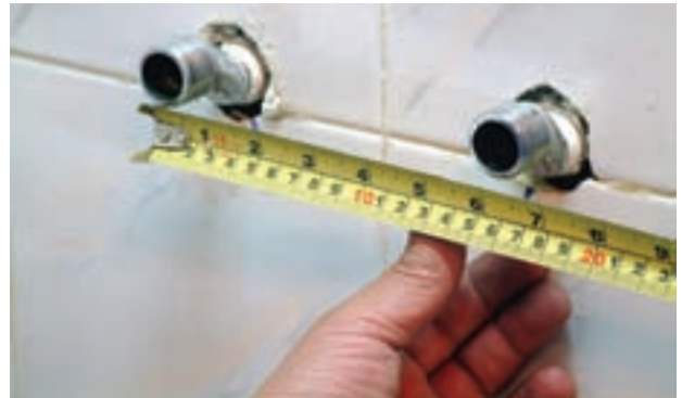
۶- کنترل اندازه‌ي وسط تا وسط دنباله‌ها به وسيله‌ي متر
