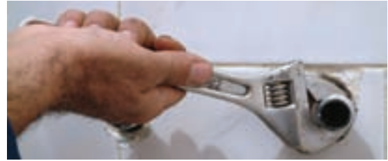
۵- سفت کردن دنباله‌ها با آچار فرانسه
