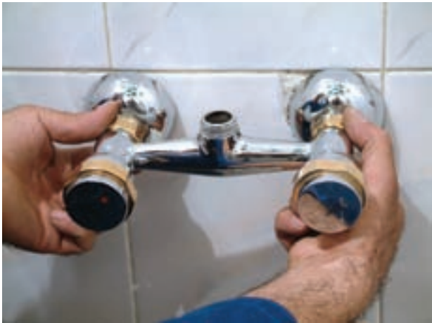
۱۰- بستن مهره‌هاي تنه‌ي شير مخلوط به دنده‌ي \frac{3}{4} دنباله‌ها به وسيله‌ي هر دو دست
