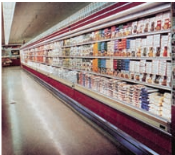
شکل ۱-۳-۱. یخچال ویتیرینی روباز مخصوص فرآورده‌های لبنیاتی
