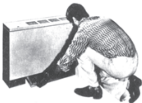
شکل ۹-۵- درآوردن فیلتر فن کویل
