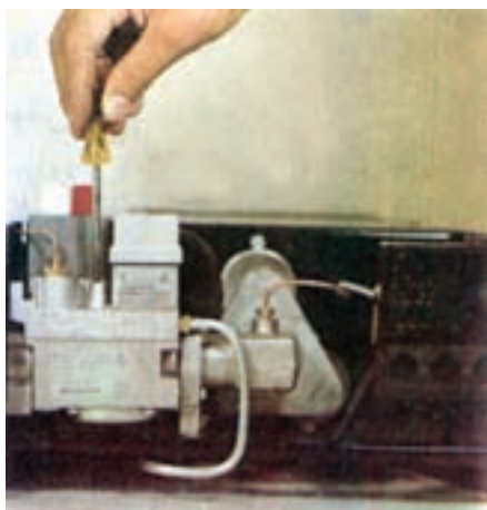
شکل ۳۲-۵ - تنظیم شعله‌ی پیلوت
