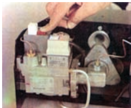
شکل ۳۴-۵ - خاموش کردن دائم مشعل
