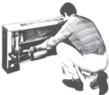
شکل ۱۰-۵- خارج نمودن مجموعه‌ی تشتک، الکتروموتور و ونتیلاتور
