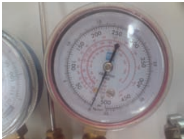
شکل ۲-۵۳- فشار سنج فشار بالای (ساده) مانیفولد
