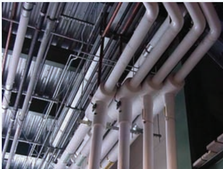
شکل ۳۴-۲- عایق‌کاری (گرمابندی) لوله‌ها
