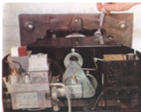
شکل ۳۰-۲- نصب مشعل روی دیگ
