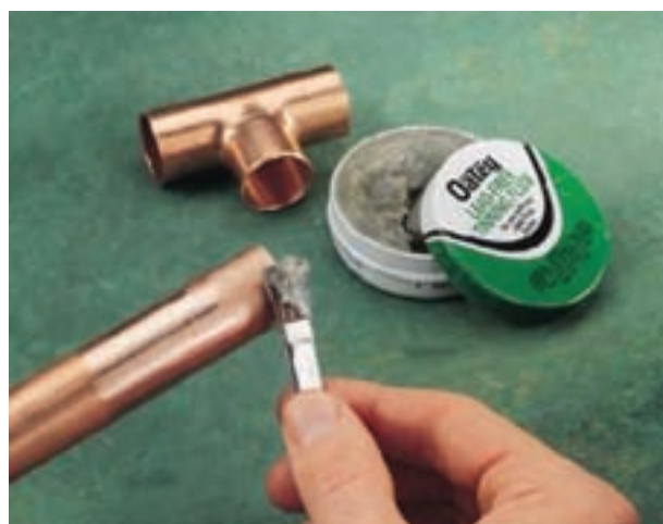
شکل ۴۲-۱- مراحل اتصال لوله‌ی مسی با فیتینگ‌های لحیمی
