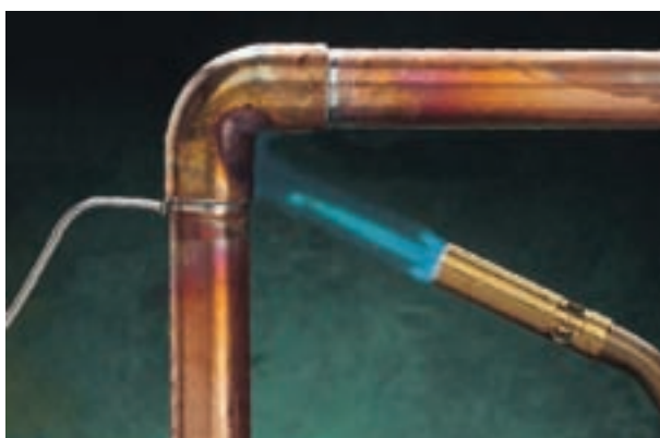
شکل ۴۲-۱- مراحل اتصال لوله‌ی مسی با فیتینگ‌های لحیمی
