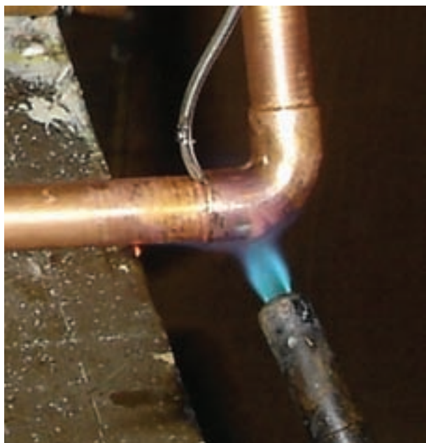
شکل ۱-۵- اتصال لوله‌ی مسی با فیتینگ لحیمی
