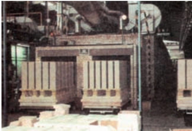
شکل ۴-۵- خشک‌کن تونلی دو قلو برای خشک‌کردن کاشی
