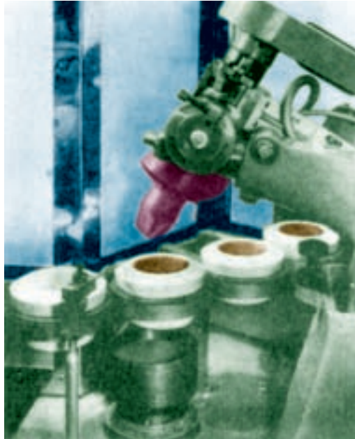
شکل ۳۸-۱- شکل دادن به فنجان با دستگاه رولر
