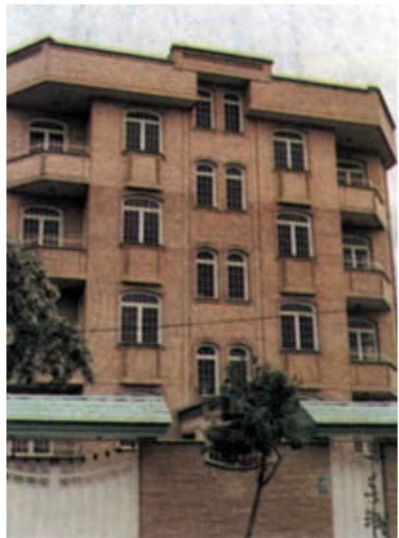
شکل ۶-۱- اجرای قوس در نمای آجری
