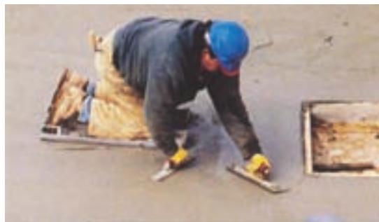
شکل ۶-۲۸- پرداخت نهایی با ابزار دستی
