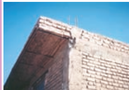
ساختمان نیمه اسکلت با شناژهای افقی و قائم که دچار کمترین آسیب شده است.
