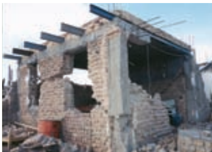
کیفیت نامطلوب بتن، عدم اجرای صحیح شناژهای افقی و قائم و اتصالات آنها موجب تخریب این سازه ی سبک و ساده شده است.
