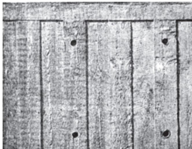
شکل ۶-۳۴- نمونه‌ای از محل‌های مهاری پر نشده
