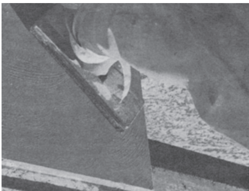
شکل ۶-۳۸- پر کردن حباب‌های سطحی با استفاده از یک ماله با سطح اسفنجی. هنگامی که دوغاب سخت شد، مواد اضافی با مالیدن سطح برداشته می‌شود تا سطح اولیه ظاهر شود.
