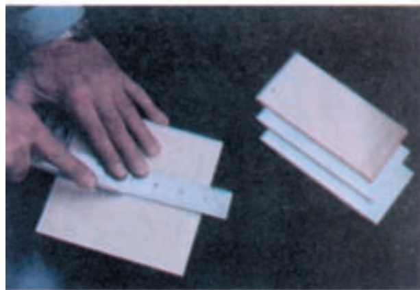
شکل ۱۲-۶- نحوه‌ی خط اندازی پشت کاشی جهت دو نیمه کردن کاشی
