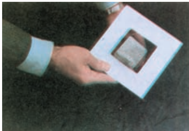
شکل ۱۰-۶- نحوه‌ی به‌وجود آوردن سوراخ مربع برای پریز و کلید در کاشی
