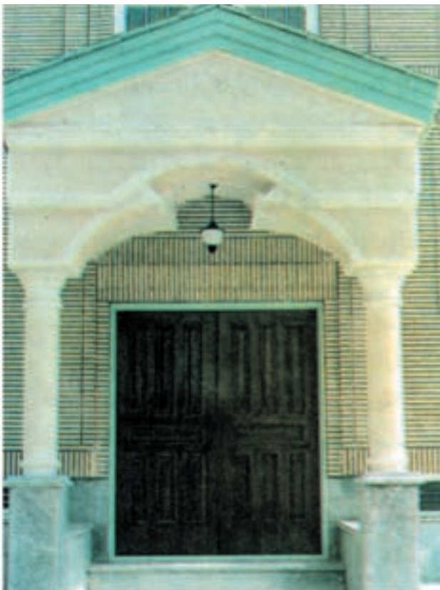
شکل ۲۰-۵- ستون‌سازی - سرستون‌سازی - قوس‌سازی سه کمانه - ابزارزنی - سیمان‌بری
