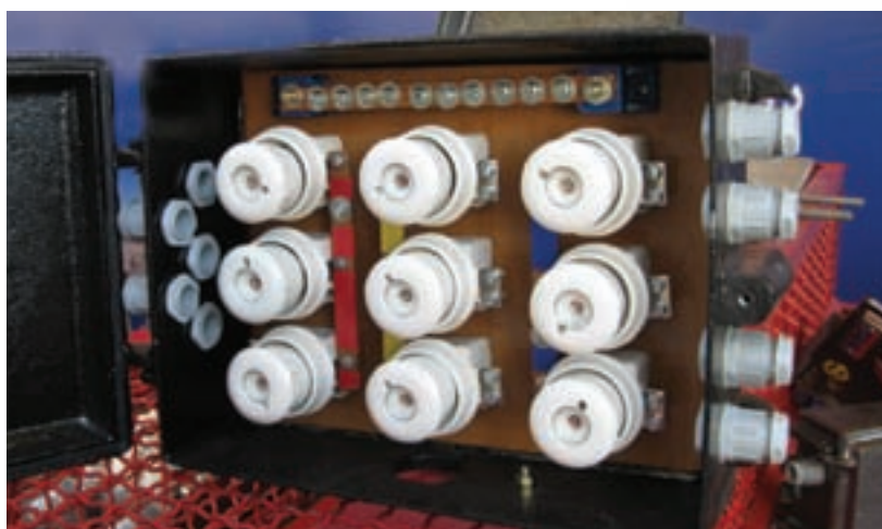
شکل ۷-۱ نمونه‌هایی از تابلوهای فیوز
