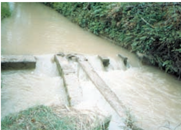
شکل ۸-۲ - مقسم ثابت
