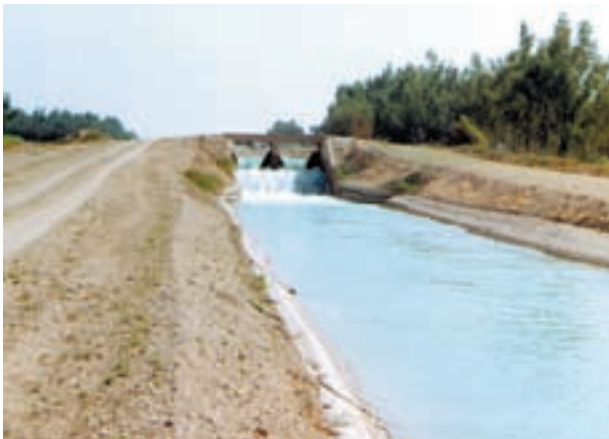
شکل ۱۷-۲- پوشش بتونی
