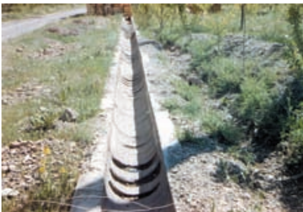
شکل ۲-۲- کانال با مقطع دوزنقه‌ای
