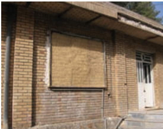
تصویر ۱۳-۲- انواع سیستم پوشال و هواکش
