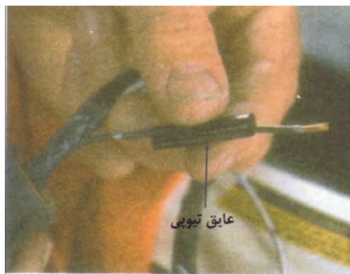
شکل ۶۴-۷- وارد کردن سیم به داخل عایق تیوبی
