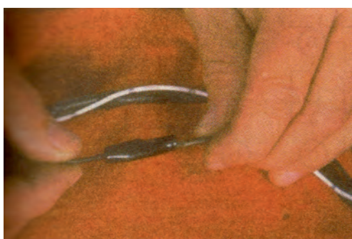
شکل ۶۶-۷- قرار دادن تیوپ عایق روی محل اتصال سیم‌ها
