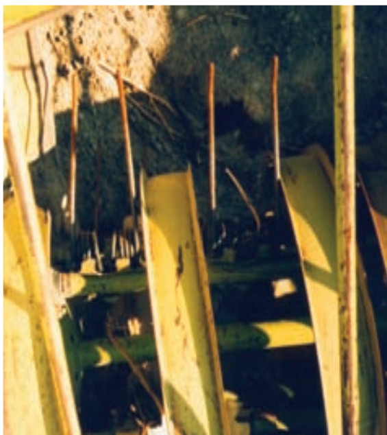
شکل ۲۱-۱- پایه انگشتی شکسته
