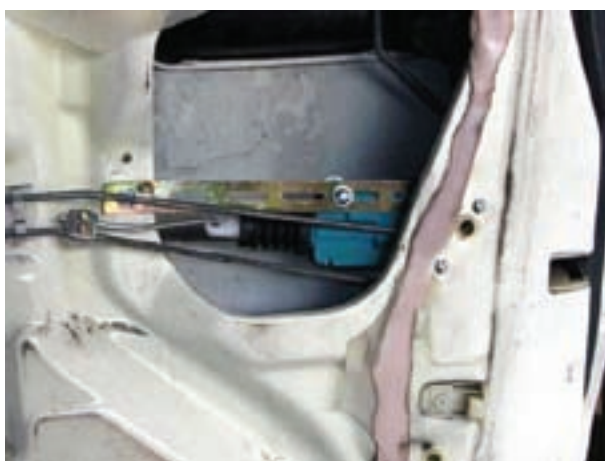
شکل ۳۷-۲- نحوه‌ی اتصال عملگر الکتریکی
