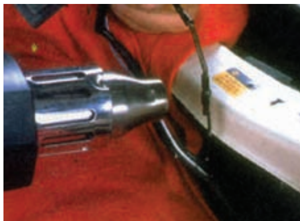
شکل ۱-۱۵۰- عایق کاری محل اتصال سیم ها
