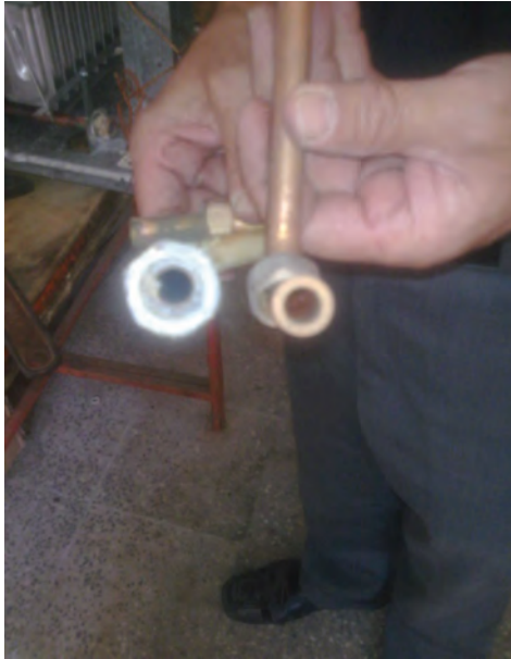
شکل ۴-۱۲- تشکیل رسوب در لوله آب گرم
