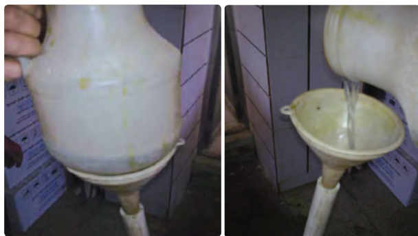
شکل ۱۹-۴- شست‌وشوی مبدل بعد از رسوب‌زدایی
