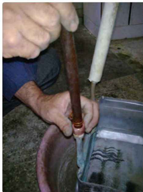
شکل ۱۷-۴- به یک طرف مبدل شیلنگ لاستیکی و طرف لوله پلاستیکی نوع PP متصل می‌شود.
