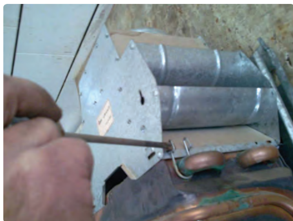
شکل ۱-۶- جدا کردن کلاهک تعدیل از مبدل
