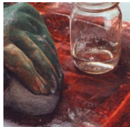
شکل ۳۵- ۱۱- پرداخت سطح کار با سیم ظرفشویی.
