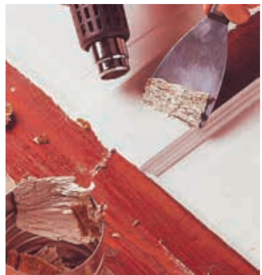
شکل ۱۲-۱۱- برداشتن رنگ به روش حرارتی.
