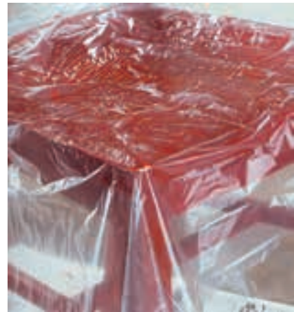
شکل ۳۳- ۱۱- پوشاندن با پلاستیک جمع کنید.
