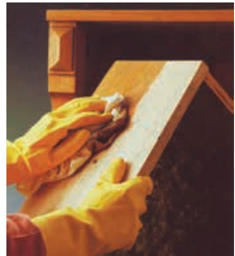
شکل ۲۱-۱۱. آستری زدن سطح کار
