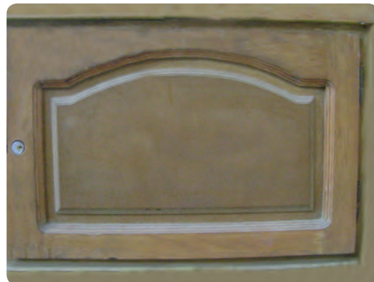
شکل ۶-۸۷ در قاب و تنکه‌ای کابینت
