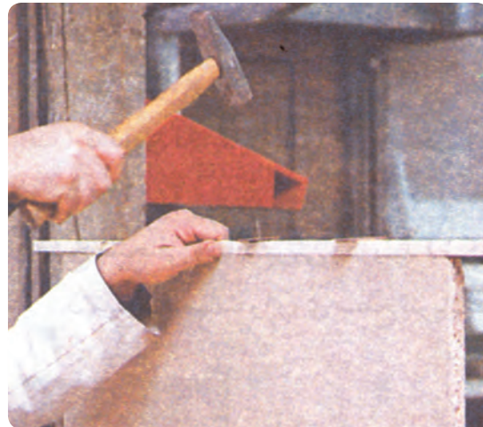
شکل ۷۸-۶ نصب زهوار چوبی لبه چسبان
