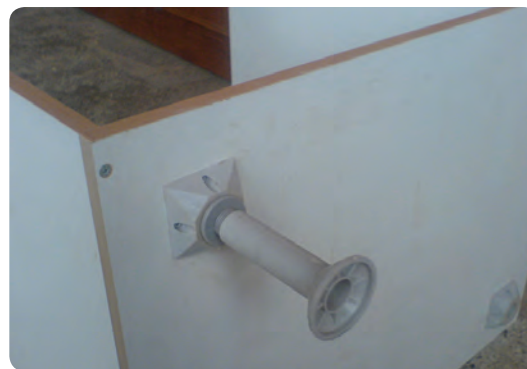
شکل ۶-۱۱۵ پایه نصب شده زیر کابینت
