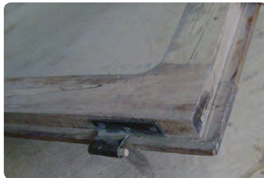
شکل ۹۱-۶ نصب لولای قابلمه‌ای در دو راهه در
