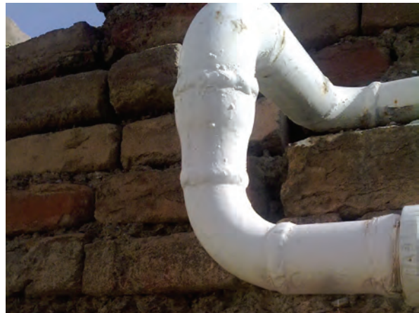
شکل ۸۲-۴ الف قبل از ورود به کنتور لوله از \frac{1}{4} به \frac{1}{2} تبدیل شده است
