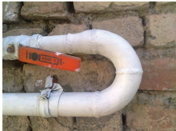
شکل ۸۲-۴ ب بعد از کنتور لوله از \frac{1}{4} به \frac{1}{2} تبدیل شده است
