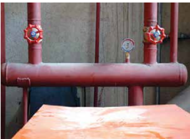
شکل ۳۲-۵- استفاده از اتصال جوشی در حرارت مرکزی
