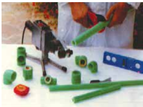
شکل ۲۷-۵- بریدن لوله به وسیله‌ی قیچی مخصوص
