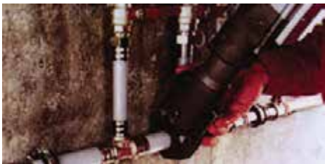
شکل ۲۳-۵ - اتصال پرسی
