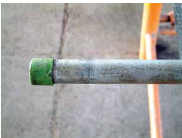
شکل ۱۶-۴ اتصال بوشن پلاستیکی به سردنده‌ی لوله
