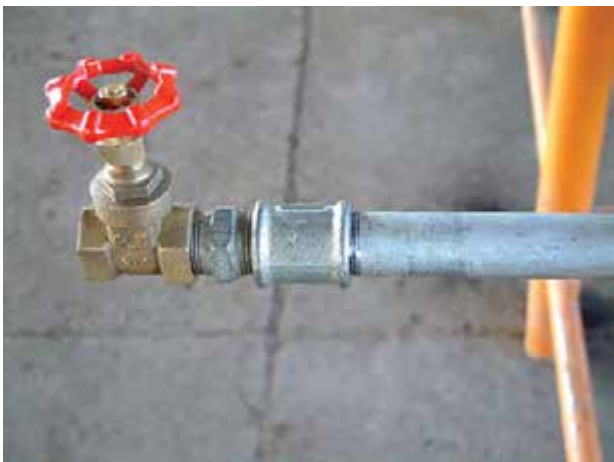
شکل ۴-۸- اتصال دنده‌ای
