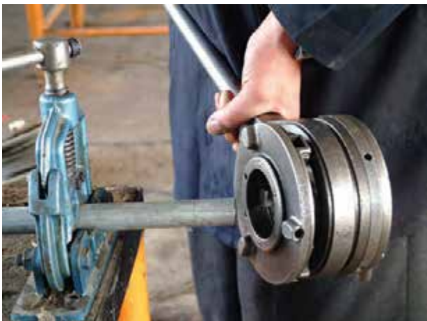
شکل ۴-۶۳- شروع حدیده کاری
