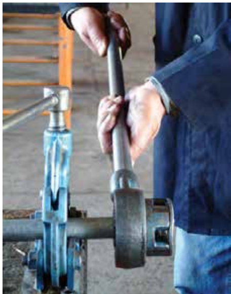
شکل ۴-۵۰- باز کردن حدیده از لوله
