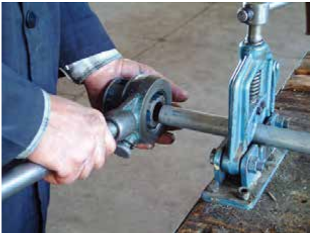
شکل ۴-۴۵- شروع حدیده کاری
