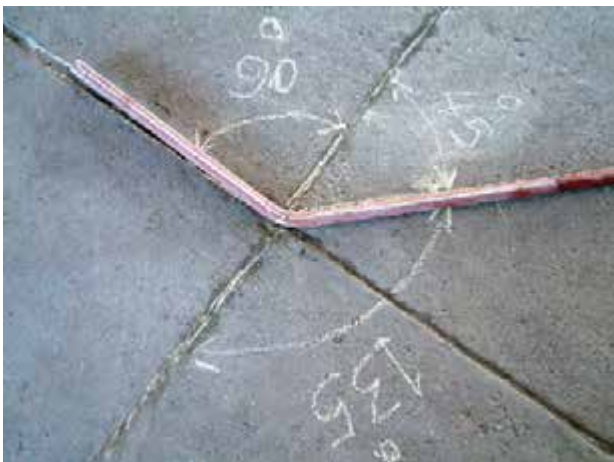
شکل ۲۹-۳- کنترل خم لوله های ۴۵ درجه
