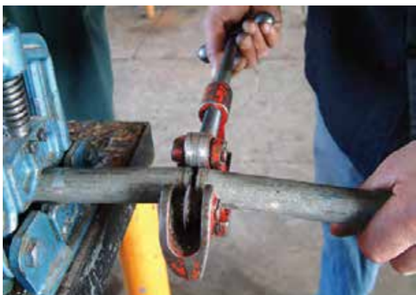
شکل ۳-۵۲- بریدن لوله‌ی محاسبه شده
