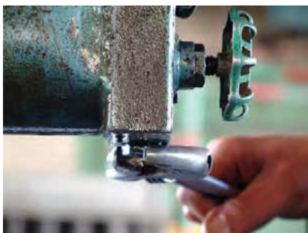
شکل ۱۴-۳- باز کردن درپوش تخلیه ی روغن
