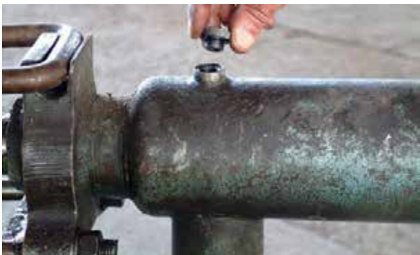
شکل ۳-۴۹- باز کردن سرپوش و بازدید روغن داخل سیلندر
