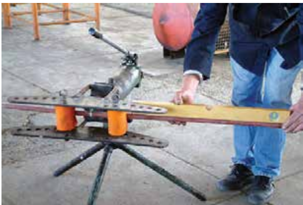
شکل ۳-۴۳- کنترل افقی بودن لوله در خم کاری
