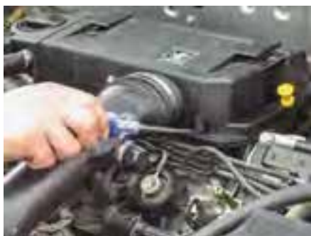
شکل (۲-۶۵) نصب در پوش محافظه فیلتر هوا
