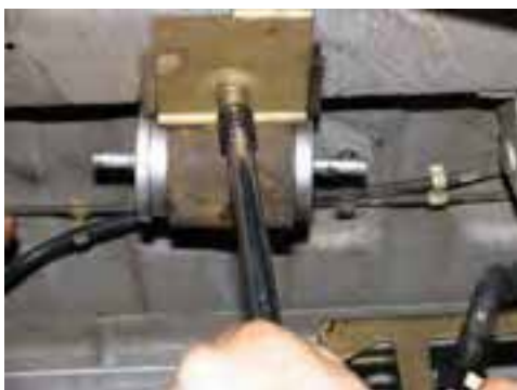
شکل (۲-۶۸) نصب فیلتر جدید
