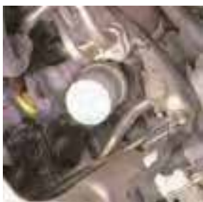
شکل (۲-۶۰) کنترل فیلتر از نظر نشتی
