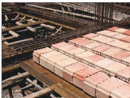
شکل ۱-۱۵۲ کاربرد بلوک سفالی در سقف
