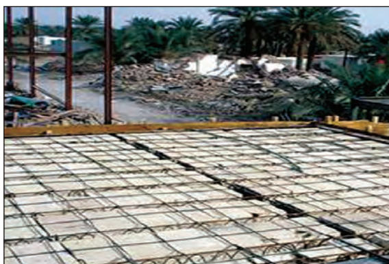
شکل ۱۳-۱ سقف تیرچه بلوک
