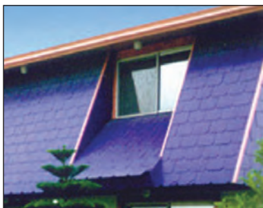
شکل ۴۷-۱ پوشش نهایی سقف شیب‌دار با آردواز
