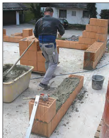
شکل ۱-۱۵۳ ساخت دیوار با بلوک سفالی
