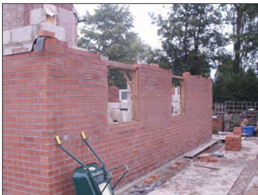
شکل ۱-۱۰۷ دیوار باربر آجری
