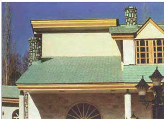
شکل ۱-۱۰۲ پوشش سقف با ورق‌های فشرده‌ی آردواز
