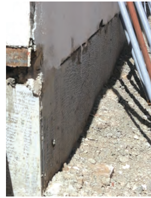
▲ شکل ۲۵-الف سنگ ازاره پای دیوار خارجی
