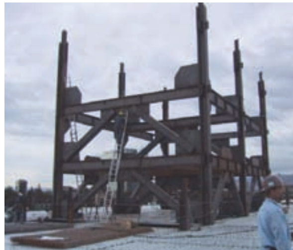
شکل ۳-۸ - تصویر یک سازه‌ی فلزی
