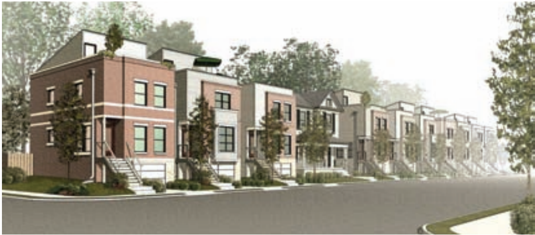
شکل ۱-۵- تصویر یک نما با تأکید بر مشخصات اجرایی آن
