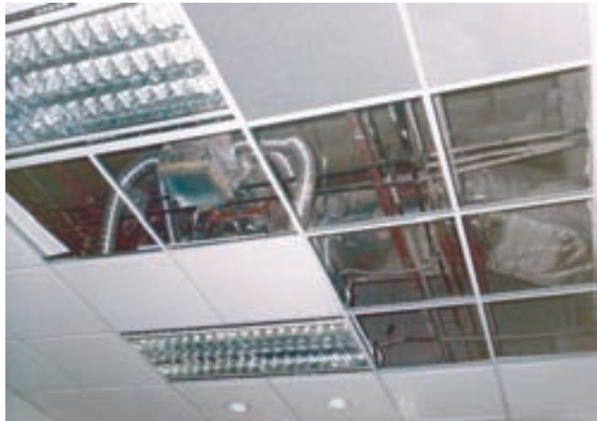
تصویر ۲۰- زیر سازی سقف کاذب
