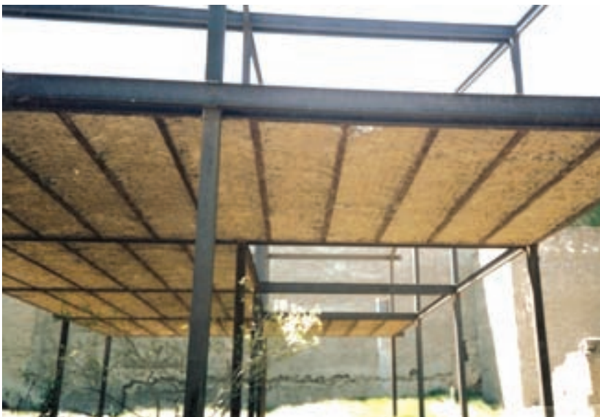
تصویر ۱۰ - تیرریزی سقف طاق ضربی
