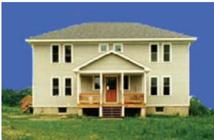
شکل ۱۶-۱- نمای ساختمان اجرا شده
